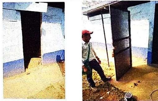
**Foto 4: Modulo 2 Se realizan los trabajos de cambio una puerta de madera deteriorada por una puerta de metal**
