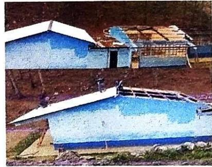
**Foto 2: Modulo 3 Se realizan los trabajos de colocacion de las nuavas laminas troqueladas, para tres aulas, un deposito de agua y una cocina.**
