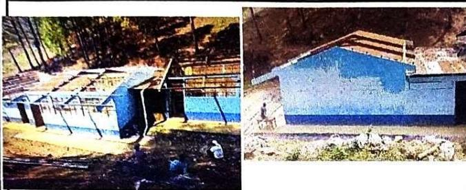
**Foto 1: Modulos 3 y 4 Cambio de costaneras deterioradas por costaneras galvanizadas de 4x2x6 para tres aulas y una cocina**
