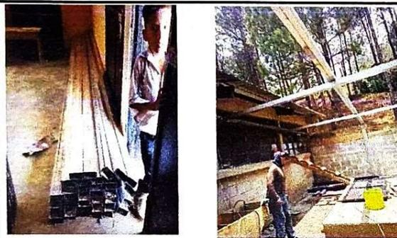
**Foto 3: Modulo 4 Se realizaron los trabajos de soldaduras de vigas , colocacion de vigas y costaneras. Cambio de techo del deposito de agua**
